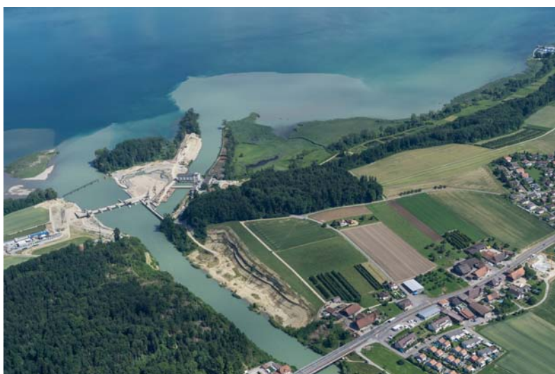
Abb.1: Mündungsbereich des Hagneckkanals in den Bielensee mit dem neuen Kraftwerk. Foto: Vinzenz Maurer, AWA
