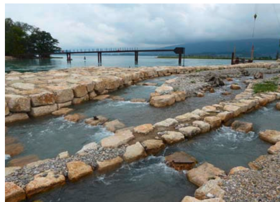
Abb.3: Umgehungsgerinne des neuen Kraftwerks Hagneck in Form eines Raugerinnebeckenpasses und mit teilweise natürlichen Bachabschnitten. Foto: Daniel Bernet
