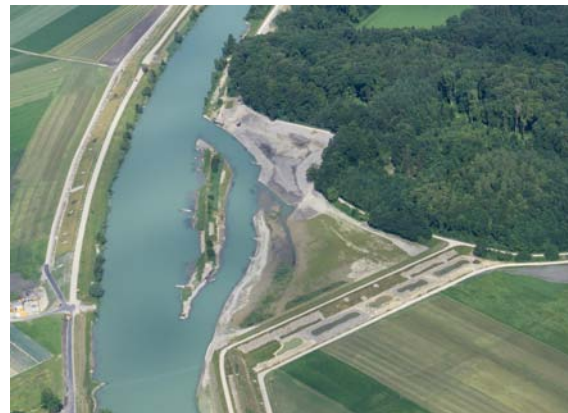
Abb.2: Rechtsufrige Aufweitung durch einen neuen Seitenarm des Hagneckkanals im Epsemoos. Eine Mittelinsel und die bei Hochwasser ausgedehnten Überflutungsflächen bieten vielfältige Lebensräume. Foto: Vinzenz Maurer, AWA
